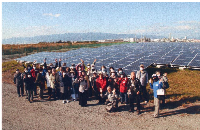
尼崎メガソーラー発電所 見学
